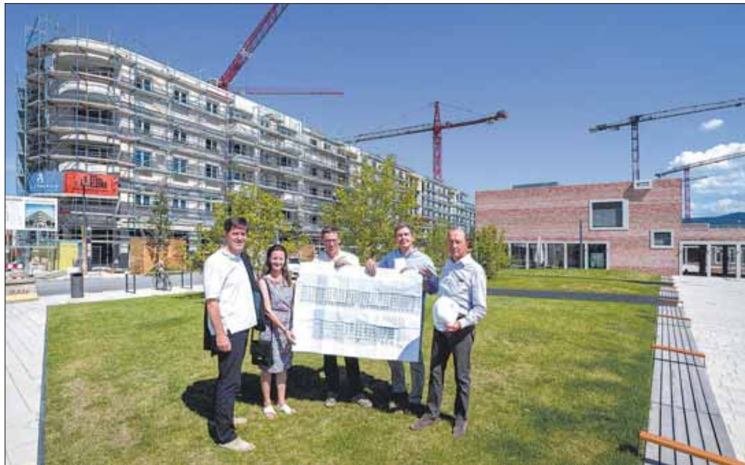
Kerstin Maixner und Gerald Dietz von der Geschäftsstelle Bahnstadt, GGH-Geschäftsführer Peter Bresinski sowie Henning Saalbach (v.l.) erklärten Bürgermeister Jürgen Odszuck (ganz links) das Konzept des architektonisch anspruchsvollen Komplexes „SE2“. Foto: Philipp Rothe
