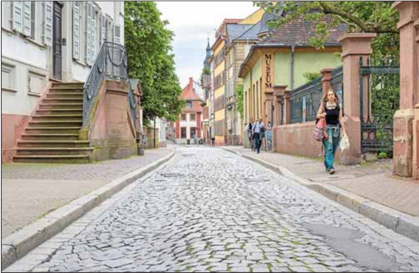
Auf Höhe des Völkerkundemuseums (rechts) ist die Hauptstraße in einem besonders schlechten Zustand. Foto: Philipp Rothe
