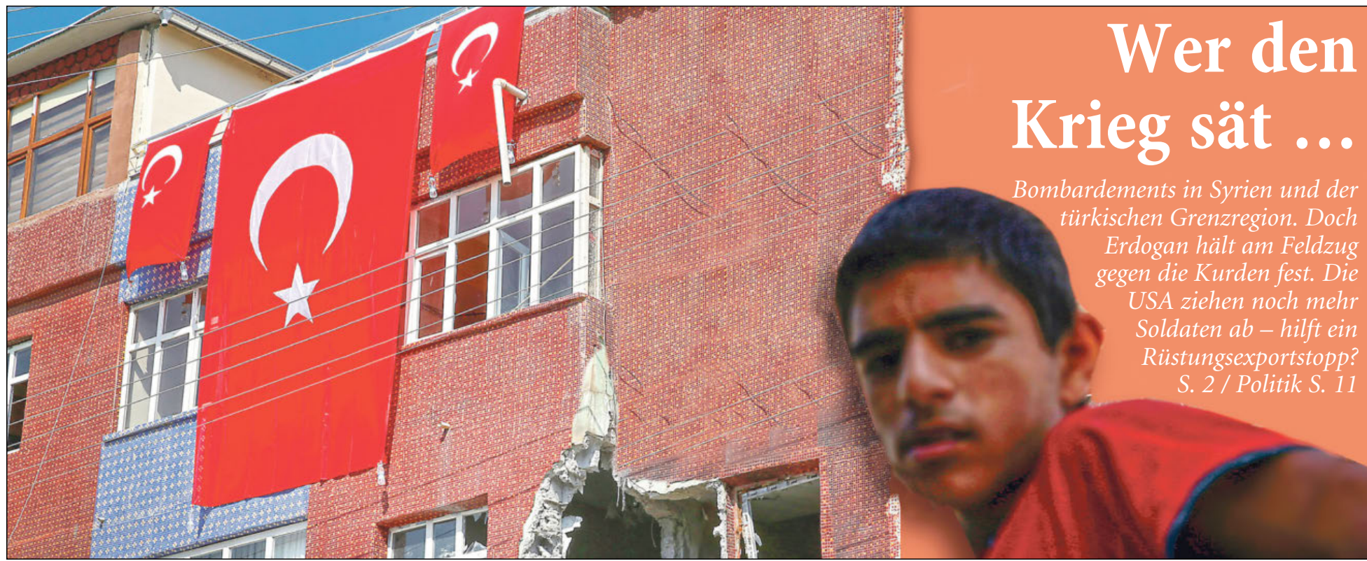
Akkakale in der Türkei: Ein Kind steht gegenüber einem Gebäude, das durch einen Mörserbeschuss aus Syrien beschädigt wurde.
